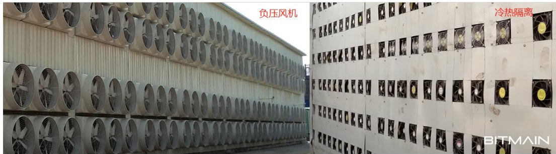
图 7 左：厂房负压风机 右：货架冷热隔离
