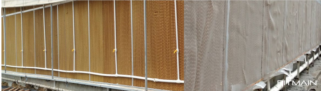
图 9 左：厂房水帘 右：如周边灰尘虫子柳絮等较多时，可在水帘位置加一层纱网阻挡
