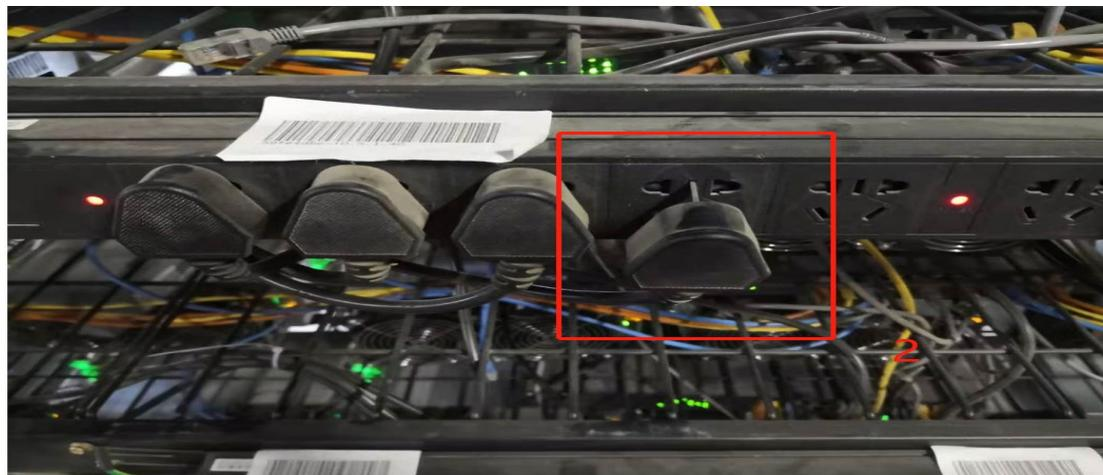
3、电源进行更换，排除电源问题，若电源无问题则是服务器控制板问题；
