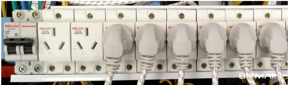
货架空开、模数化插座 不要采购配合松动的插座和电源线
